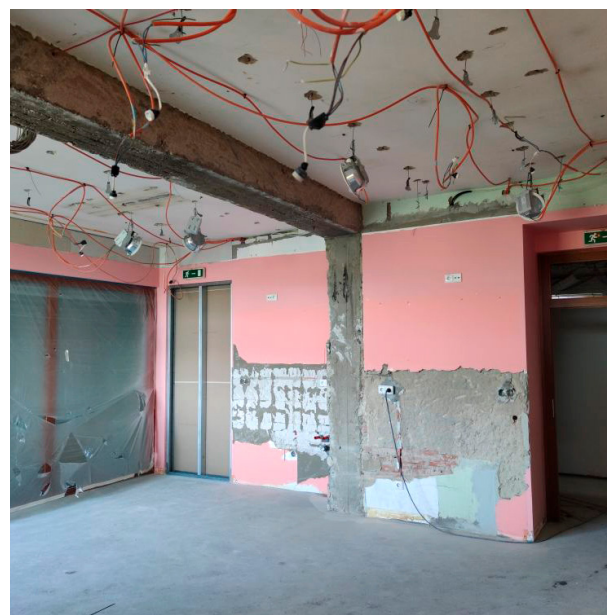
Herňa pred rekonštrukciou
